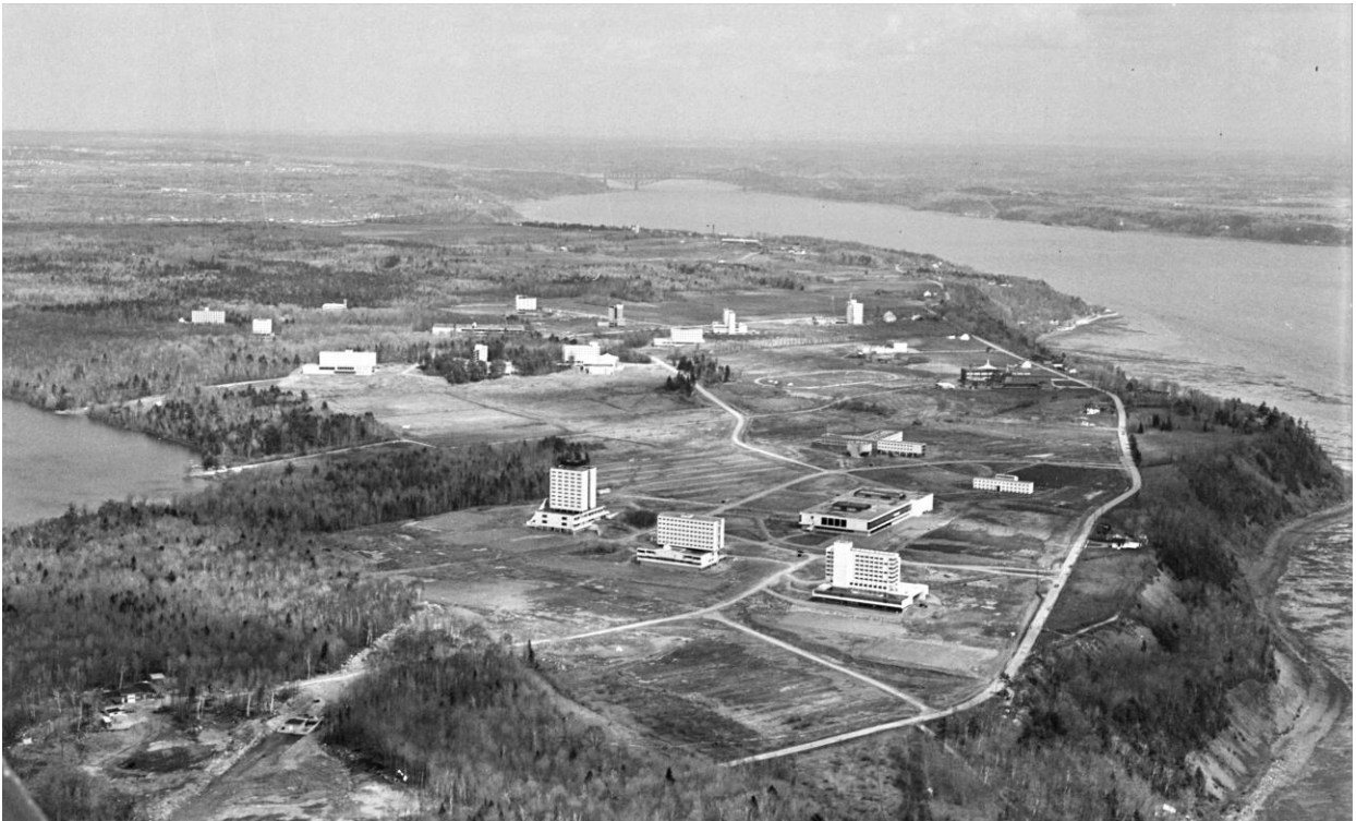
Campus intercommunautaires, 1966 Crédit photo : BANQ
