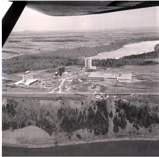
Chantier Campus Notre-Dame-de-Foy vers 1965 Archives SHSAD
